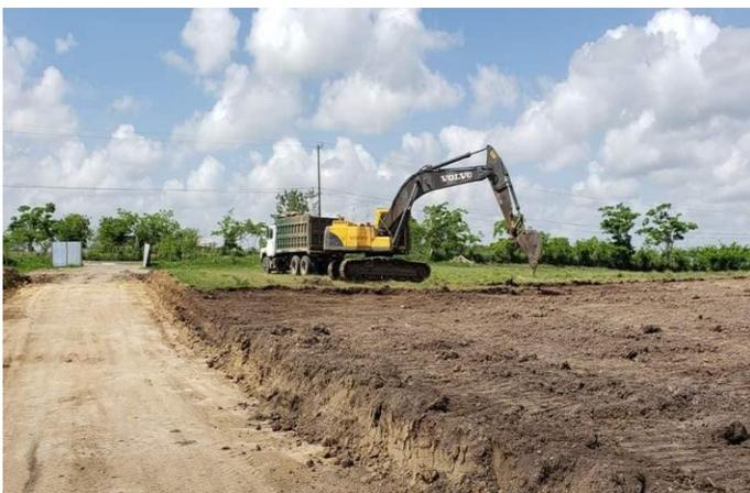
Los trabajos de construcción del nuevo cementerio Municipal avanzan vertiginosamente. Ya la mayor parte de la verja perimetral ha sido construida y en estos momentos se realizan los trabajos de nivelación, remoción de capa vegetal y reposición de relleno para cimentar el área donde iniciaremos la construcción de un panteón.
