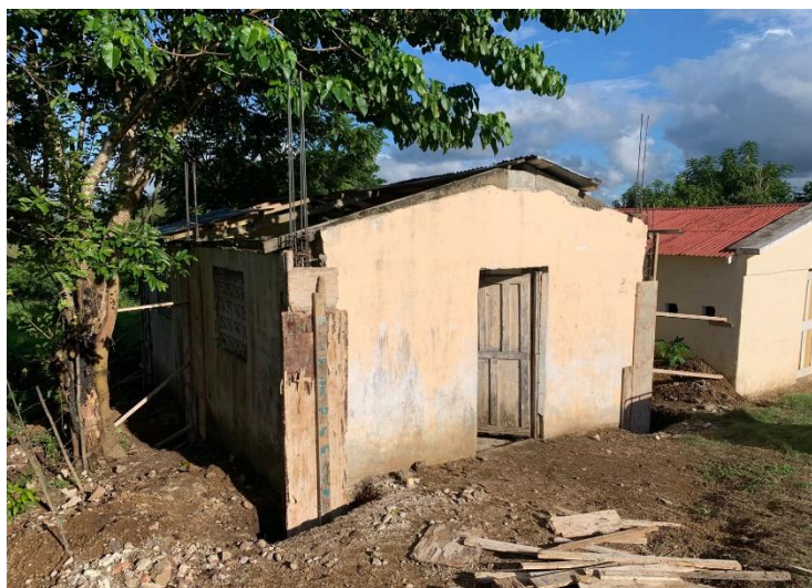
Sector Sabana Grande de El Cuy. Remodelación Centro Comunal: refuerzo de edificación con columnas de hormigón, construcción losa de techo en hormigón, con una inversión de 446,525.24
